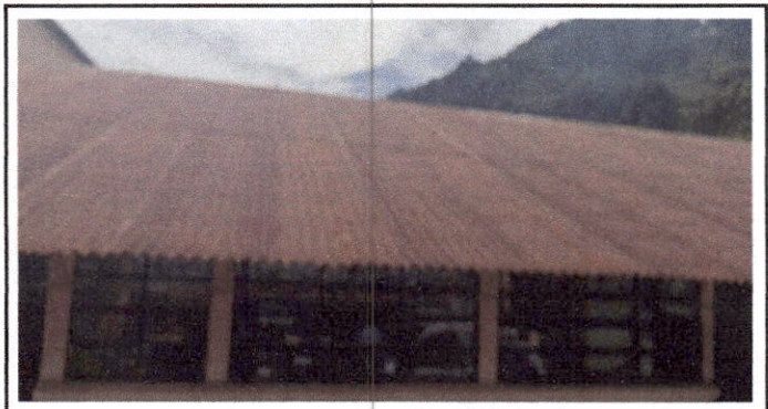
Foto 2: SUSTITUCIÓN DE CAPOTE DE LAMINA, PARA LAMINA TROQUELADA.
