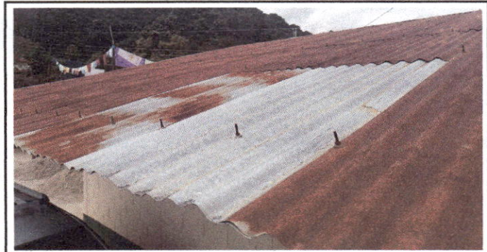
Foto 3: SUSTITUCIÓN DE ELEMENTOS DE FIJACIÓN.
