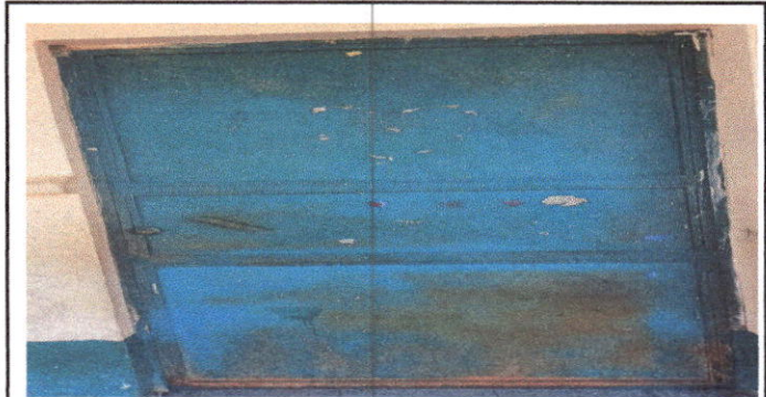
Foto 4: SUSTITUCIÓN DE PUERTA 1-2.93 MTS
